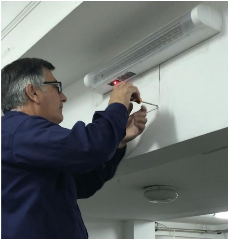
Reposición de luces de emergencia nuevas e instalación donde faltaba, con sus respectivas señalizaciones.
